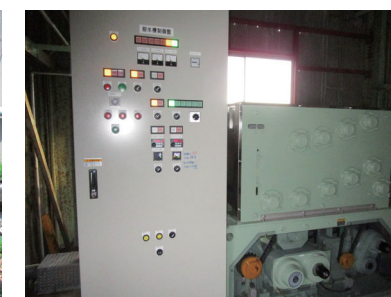
②排水汚泥脱水機更新 (田原開発センター)
